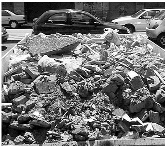
Figura 5 – Contaminação de resíduos de construção e demolição por outros resíduos
