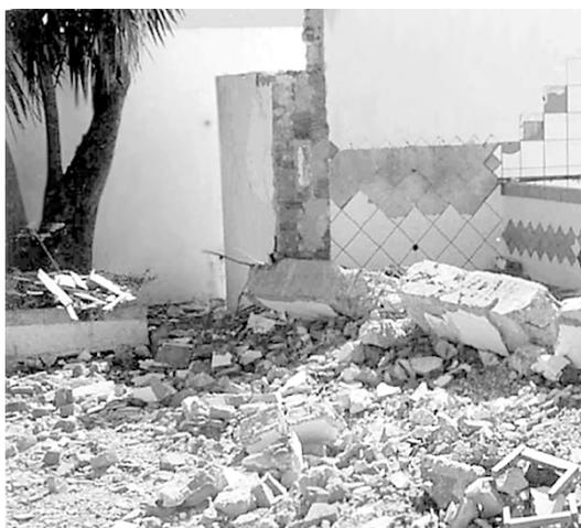
Figura 6 – Mistura de componentes construtivos do resíduo de construção e demolição pela ausência de gestão em demolições
