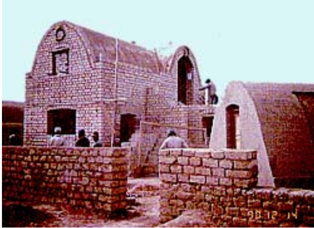
Figura 3 - Vivienda de la comunidad de los Uru Puquina, ubicada en la Cuenca del Lago Poopó, en el Departamento de Oruro
