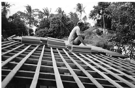
Figura 22 – Telhado para telhas cerâmicas com grande consumo de madeira
