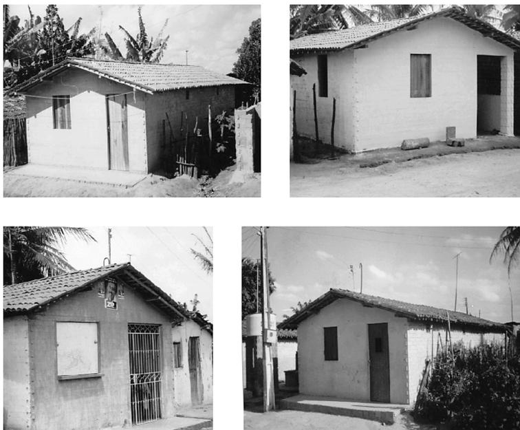
Figura 19 – Casas de tijolos prensados de terra crua
