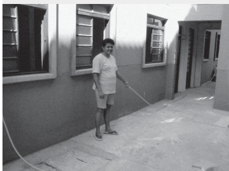
c) Ausência de infra-estrutura para a manutenção das áreas comuns (Campinas "E")
