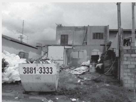
d) Casa totalmente destruída (Valinhos)
