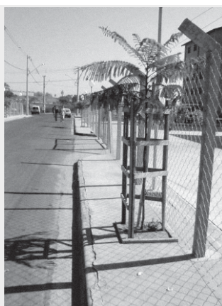
b) Calçada com arborização interferindo na circulação de pedestres (Campinas "E")
