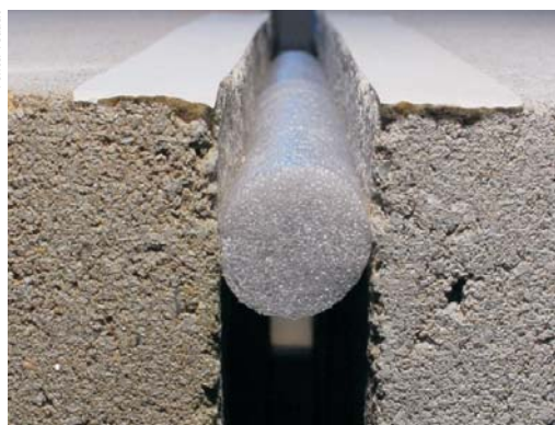
Figura 13: Proporção entre a dimensão da junta, do corpo de apoio e do selante
