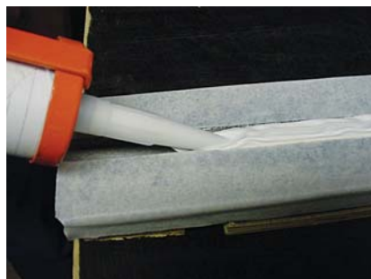
Figura 32: Aplicação do selante, garantindo preenchimento total da junta
