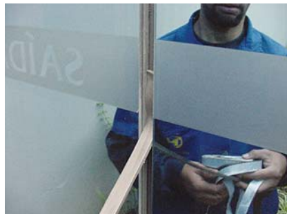
Figura 15: Detalhe da instalação de fita isoladora com uma face autoadesiva
