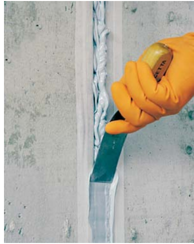
Figura 4: Avaliação da facilidade de acabamento
