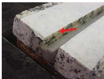
Figura 29: Aplicação de primer na superfície, antes da aplicação do selante
