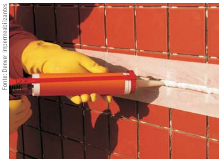
Figura 3: O selante deve apresentar facilidade de extrusão, tanto no inverno como no verão
