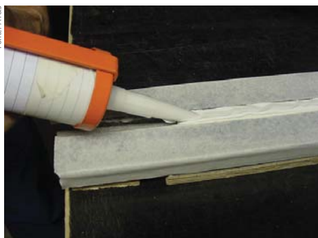
Figura 24: Detalhe do bico com corte a 45° e com largura igual à da junta para facilitar a aplicação e o preenchimento da junta
