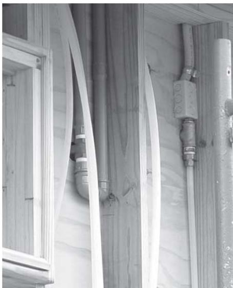
Figura 43: Colocação dos tubos PEX
