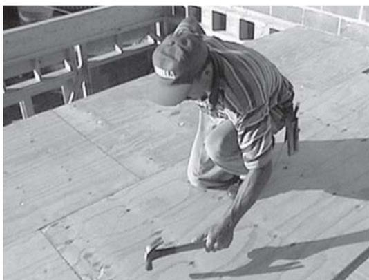
Figura 22A: Colocação das chapas laminadas
