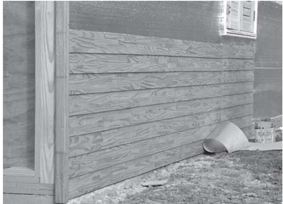
Figura 18: Manta dobrada na junção com a esquadria
