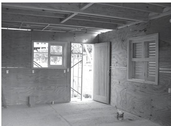
Figura 15: Chapas sem cortes e dispostas horizontalmente
