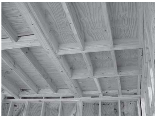
Figura 23: A estrutura sob o banheiro
