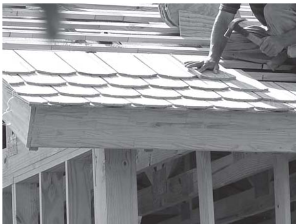
Figura 29: Colocação das telhas
