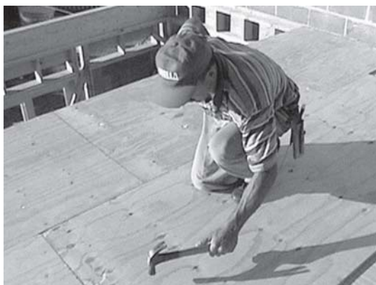
Figura 22A: Colocação das chapas laminadas
