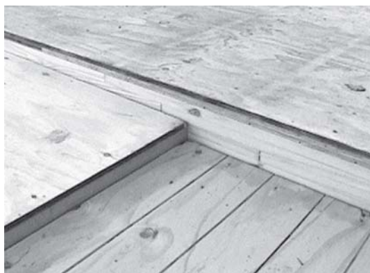
Figura 24: Rebaixamento na área do box
