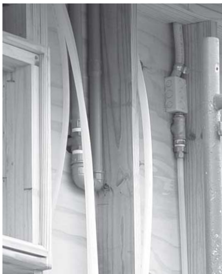
Figura 43: Colocação dos tubos PEX
