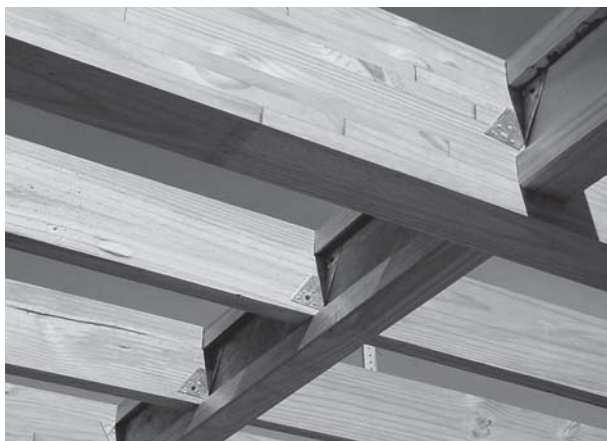
Figura 21: Ligação entre os componentes da estrutura do entepiso
