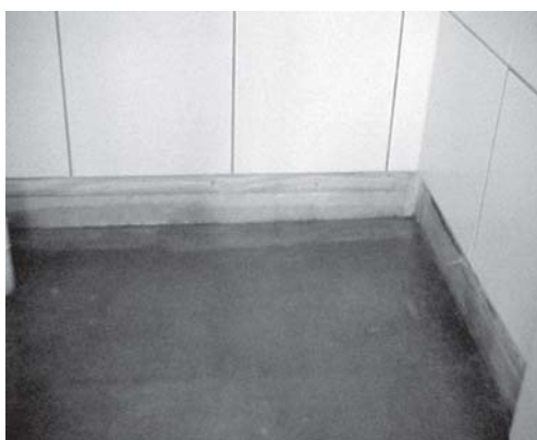
Figura 40: Aplicação da fibra de vidro
