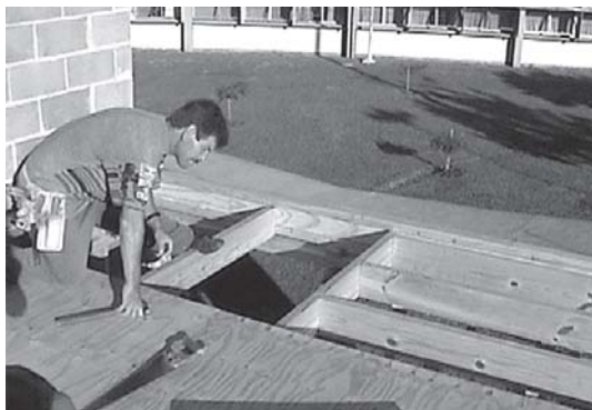
Figura 37: Estrutura da laje do banheiro
