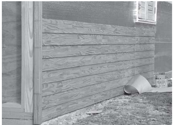
Figura 18: Manta dobrada na junção com a esquadria
