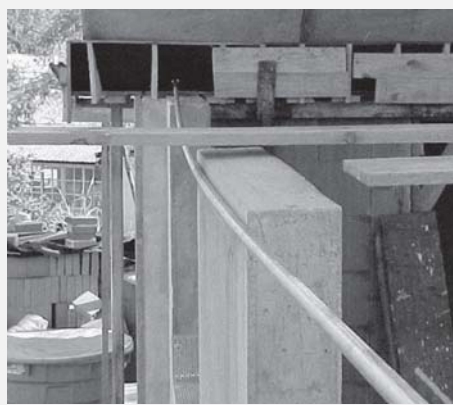
13 Andaime para travamento
