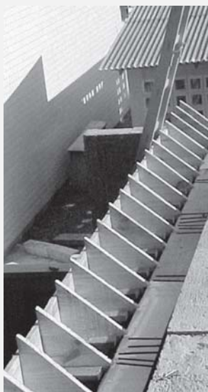
8 Colocação da argamassa de nivelamento
