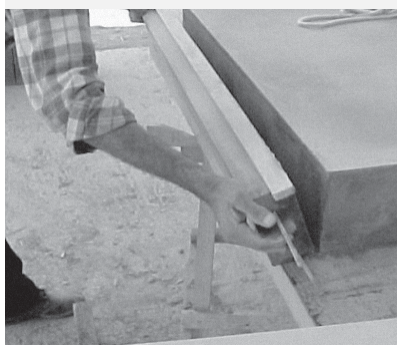
12 e 13 - Ganchos e cordas utilizados no içamento
