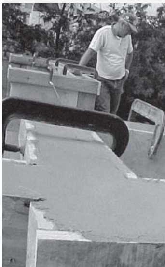
7 Formas para a camada de regularização
