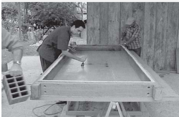
I - Aplicação de desmoldante
