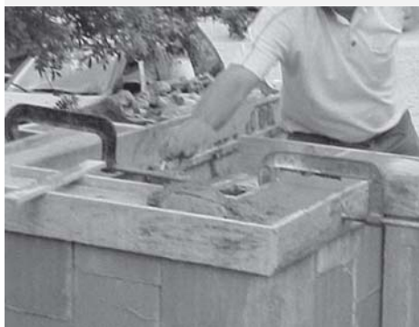
5 Colocação da chapa perfurada galvanizada
