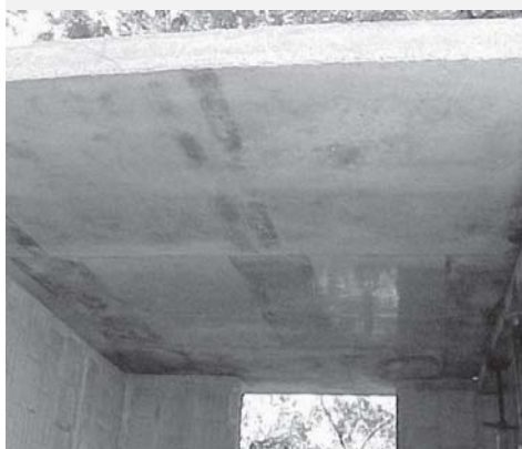
12 Içamento e colocação dos painéis-laje
