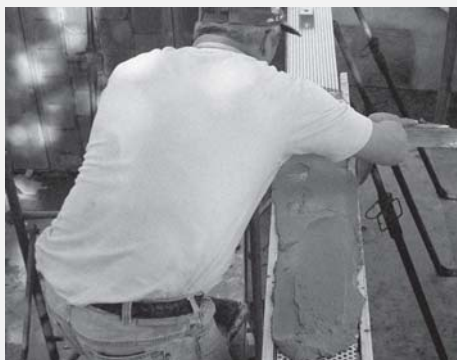
6 Ligação entre os painéis verticais
