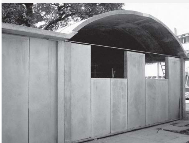
Figura 9 - Seqüências de montagem do protótipo
