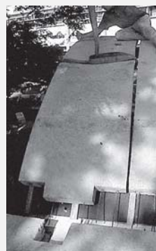
16 Painel-laje sendo içado e posicionado
