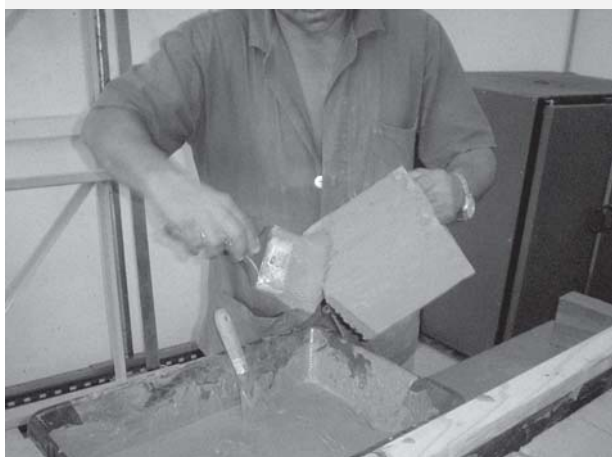
3- Aplicação da argamassa polimérica
