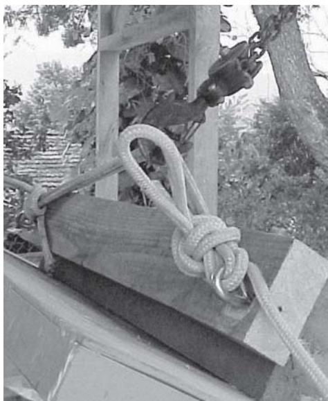
14 - Painel sendo içado
