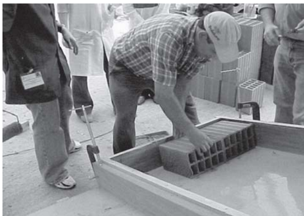
2 - Colocação dos blocos
