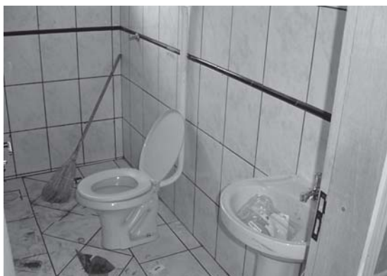
Figura 31 – Banheiro – cerâmicas e louças
