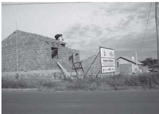
Figura 20 – Vista geral das unidades em construção
