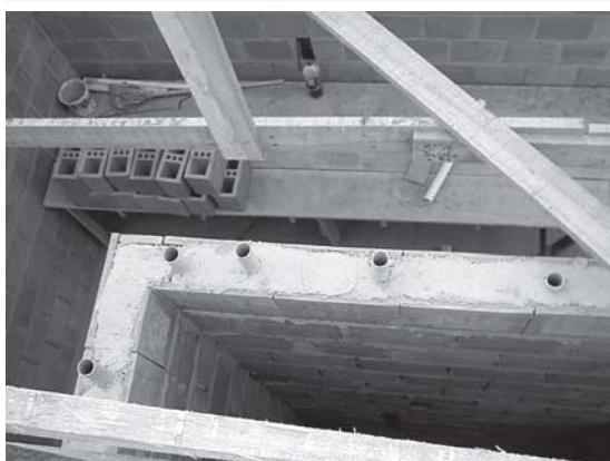
Figura 19 – Esperas deixadas na cinta para passagem de tubulações
