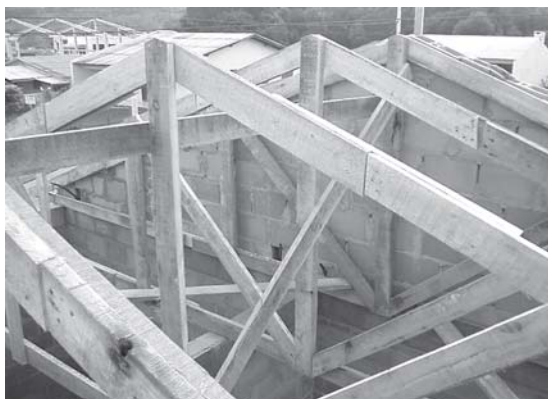
Figura 27 – Detalhe da estrutura do telhado
