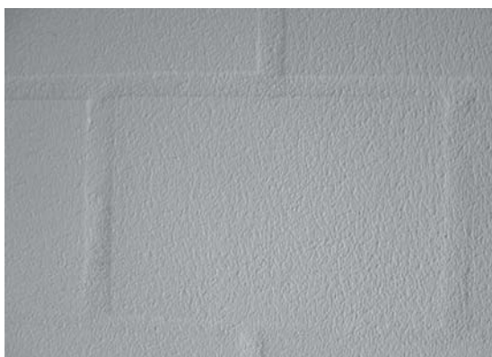
Figura 34 – Revestimento interno de textura sobre o bloco
