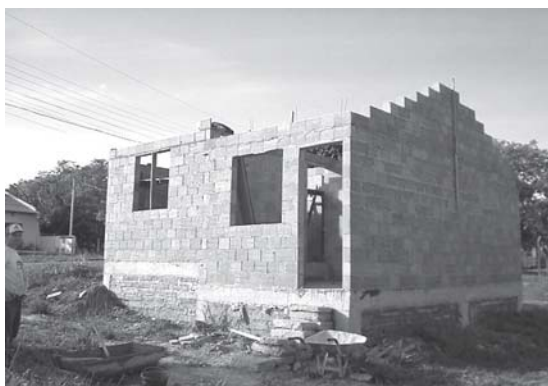
Figura 21 – Término das alvenarias – casa em desnível
