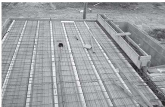
Figura 25 – Montagem da laje da casa de dois andares
