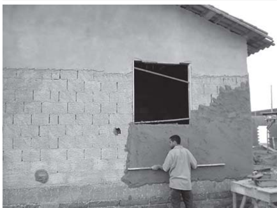
Figura 28 – Execução de revestimento
