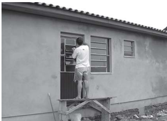
Figura 29 – Vista de aberturas e colocação de vidros
