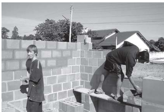
Figura 16 – Execução das alvenarias
