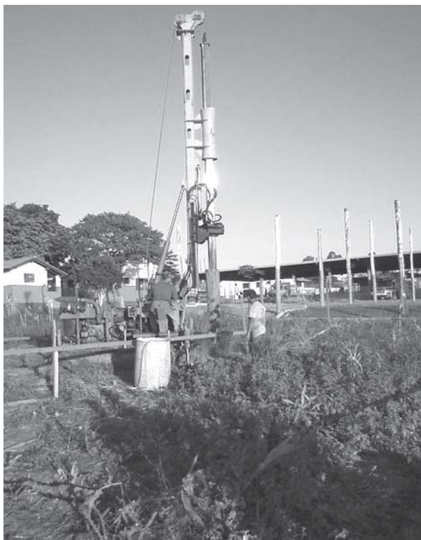
Figura 12 – Execução das fundações
