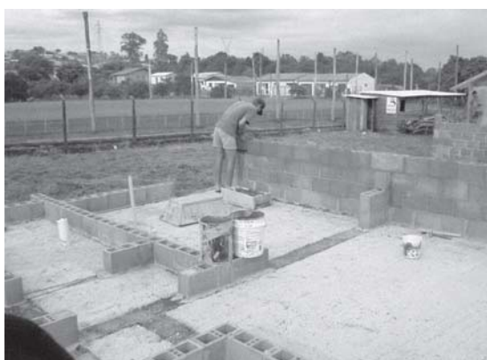
Figura 15 – Alvenarias – destaque da 1ª fiada
