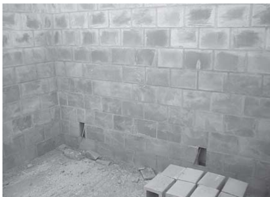
Figura 17 – Detalhe do bloco para caixa de luz
