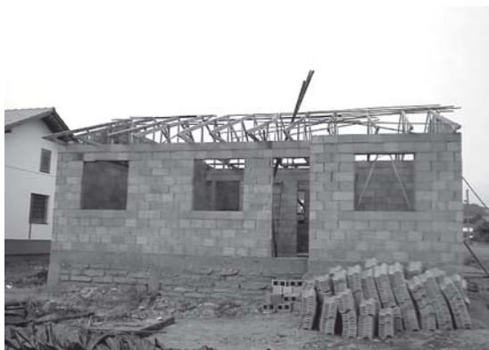
Figura 26 – Montagem da estrutura do telhado
