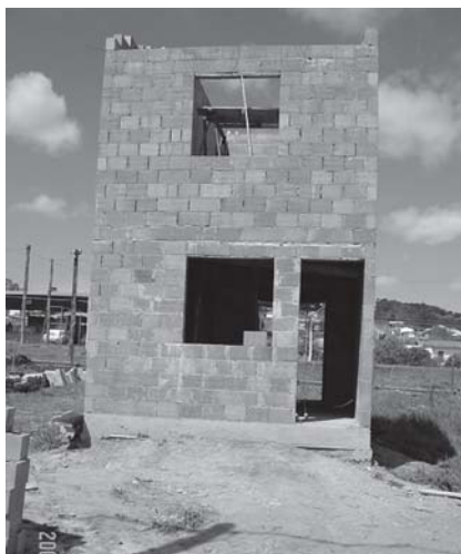
Figura 23 – Término das alvenaria – casa de dois andares
