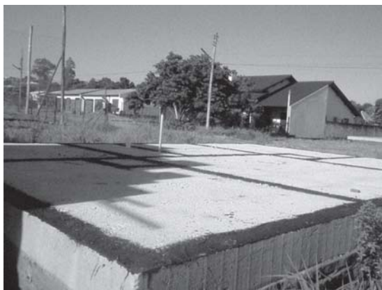
Figura 14 – Impermeabilização das vigas de fundação
