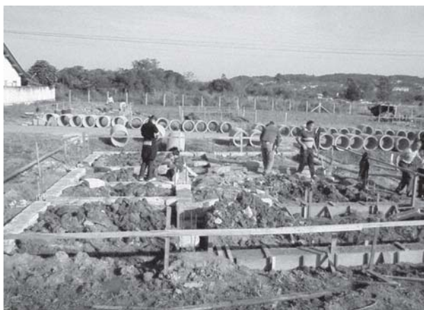
Figura 13 – Compactação do solo de contrapiso
