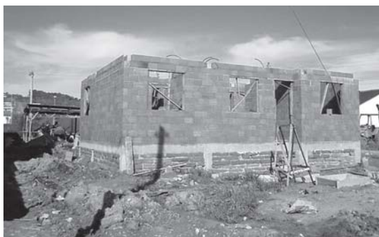
Figura 24 – Término das alvenarias – casa de quatro dormitórios
