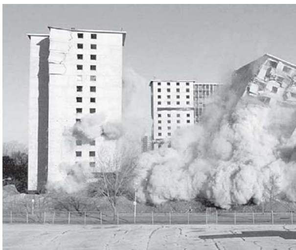
Figura 2 – O presídio do Carandiru sendo demolido por ter se tornado socialmente obsoleto
