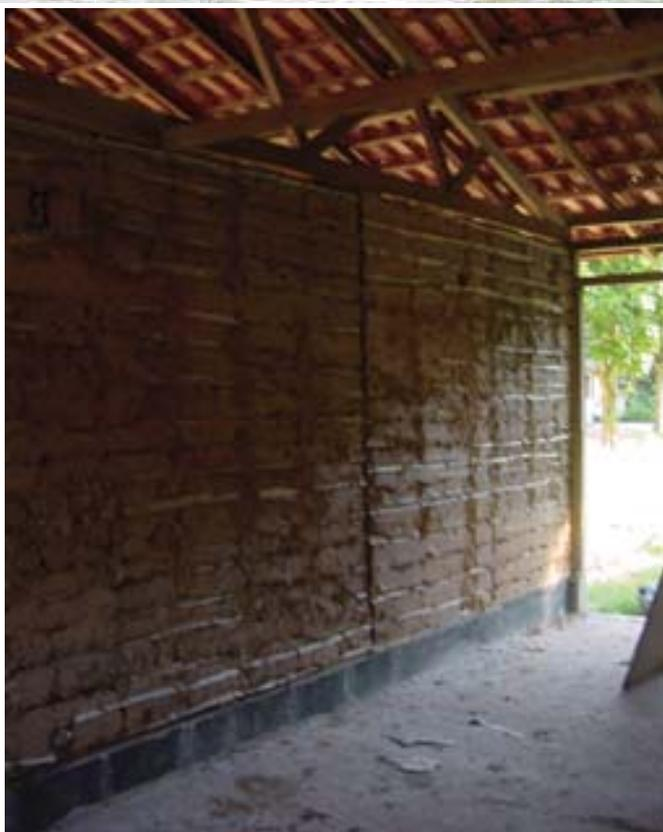
Figura 33. Enchimento das paredes do Bloco-1 com *barro-bambu*.
