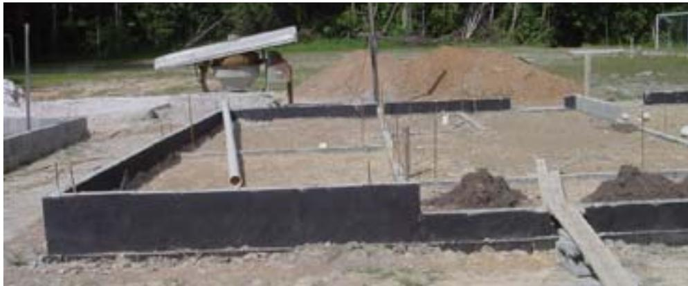
Figura 14. Impermeabilização da fundação.
