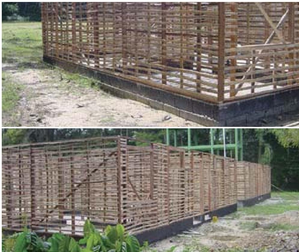
Figura 18. Travejamento e cintamento dos painéis.
