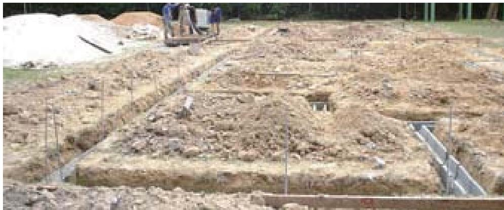
Figura 10. Instalação de chumbadores.
