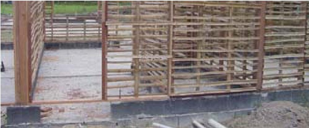
Figura 17. Painéis de parede instalados.
