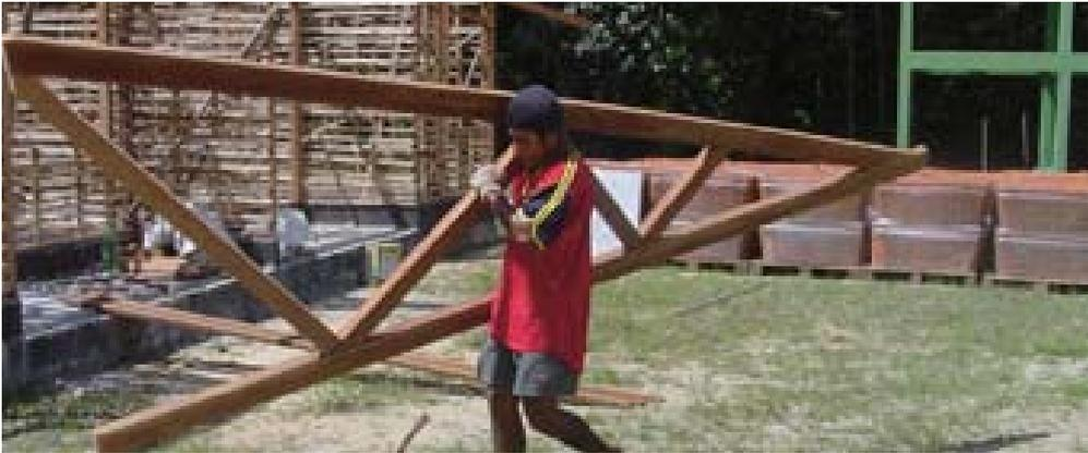
Figura 4. Meia-tesoura sendo transportada para instalação.
