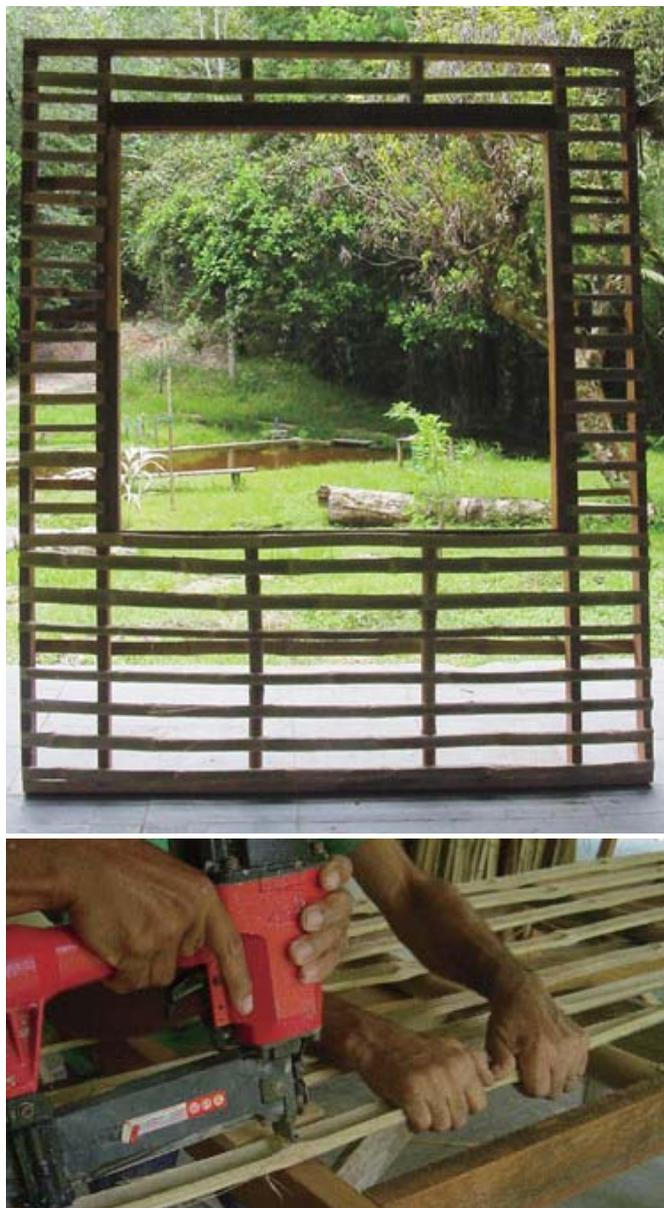
Figura 3. Painel-janela. Grampeando ripas de bambu no painel.
