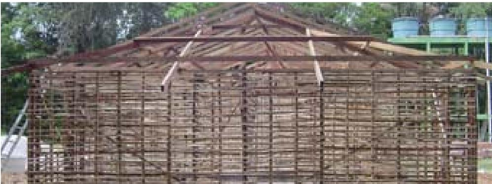
Figura 20. Terças das extremidades L-O instaladas.
