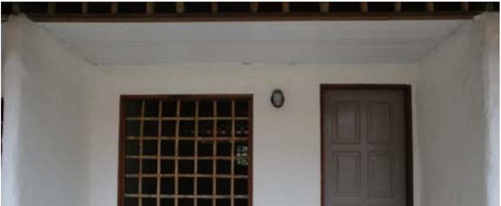
Figura 40. Forro em PVC de refugo de obra.
