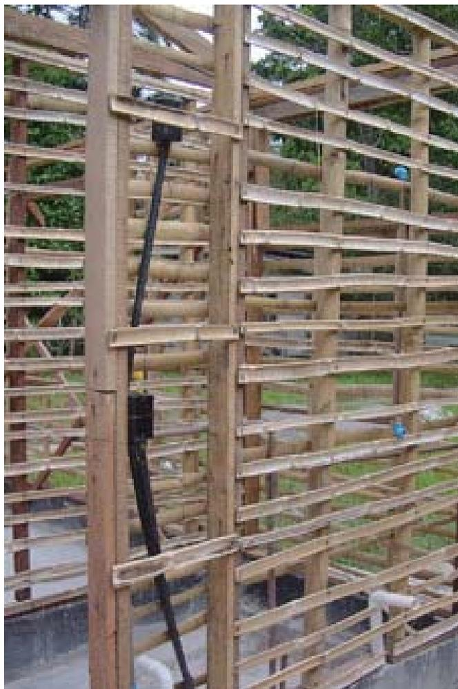
Figura 32. Instalações elétrica e hidráulica embutidas nos painéis.
