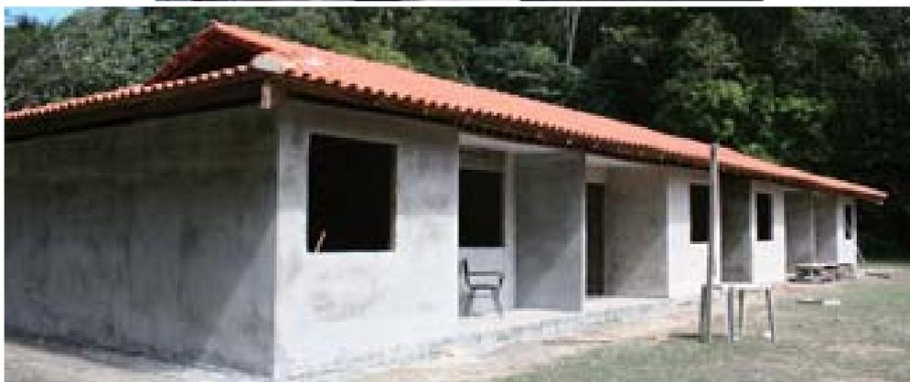
Figura 38. Emboço em paredes no Bloco-1.
