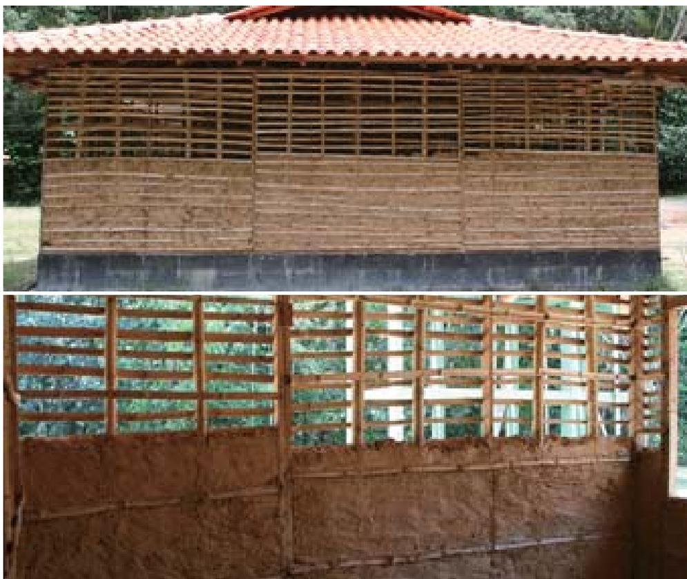
Figura 35. Enchimento das paredes do Bloco-2 com *barro-bambu*.
