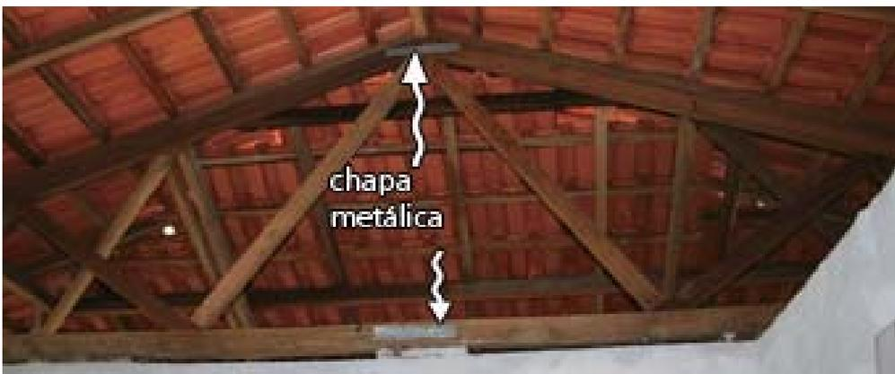
Figura 5. Conexão de duas meia-tesouras com chapa metálica pregada.
