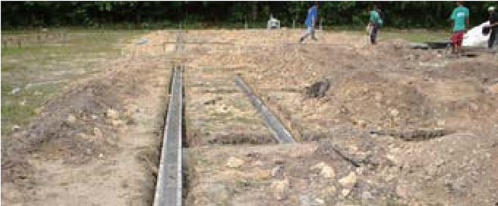
Figura 9. Assentamento de blocos-canaletas no baldrame.
