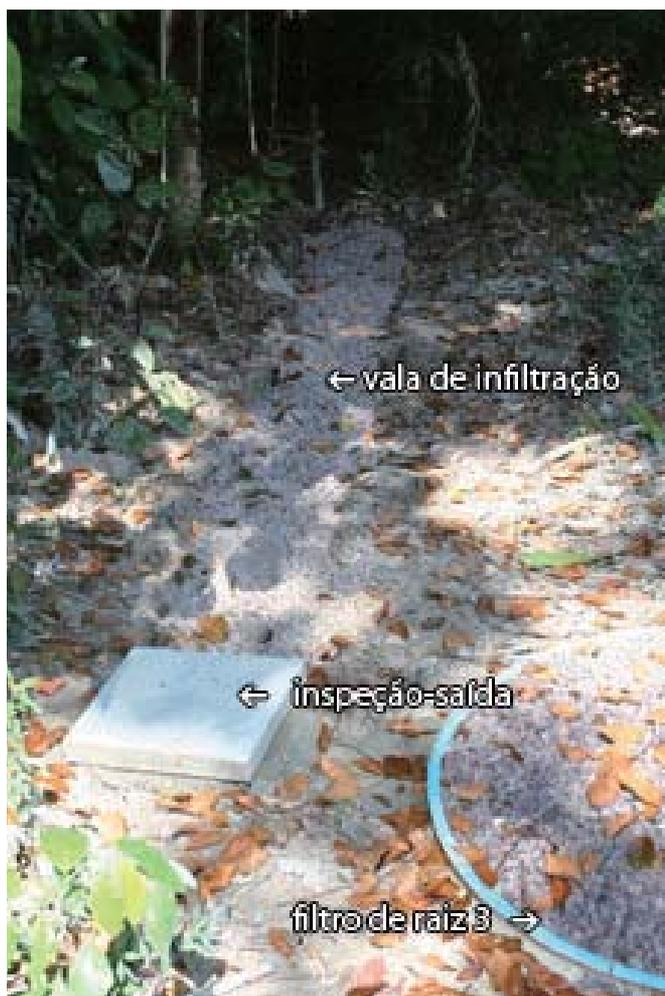
Figura 31. Filtro de raiz, inspeção de saída e vala de infiltração da ETEE3.
