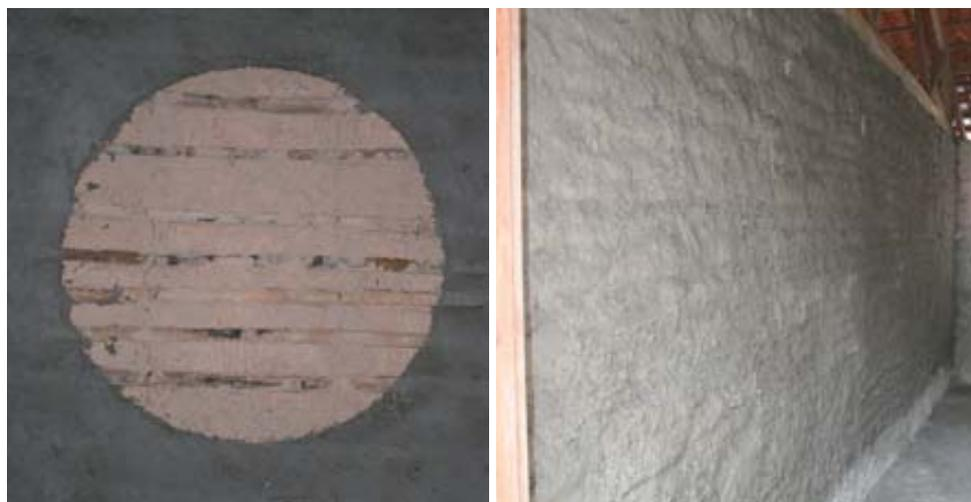
Figura 37. Chapisco nas paredes da *Janela da Verdade* na casa-4 e na sala da casa-8, Bloco-2.
