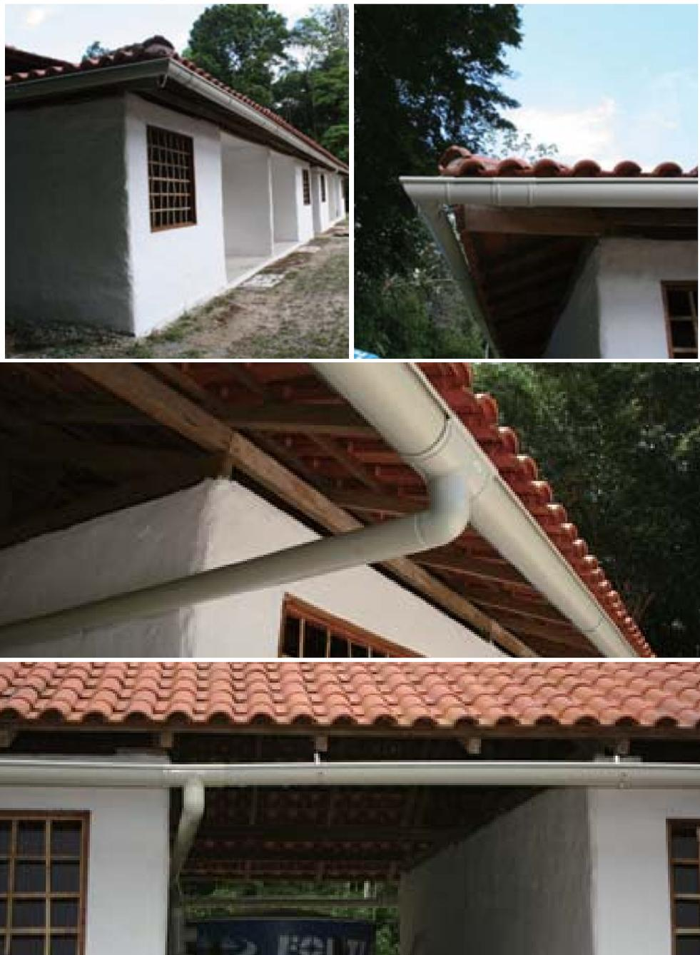
Figura 51. Calha de captação de águas pluviais.
