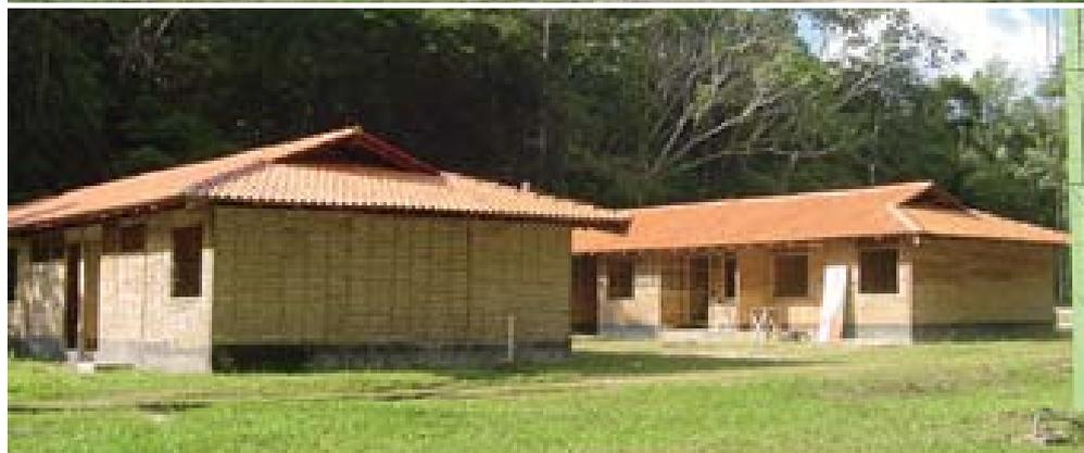
Figura 34. Enchimento das paredes dos Blocos 1 e 2 com *barro-bambu*.
