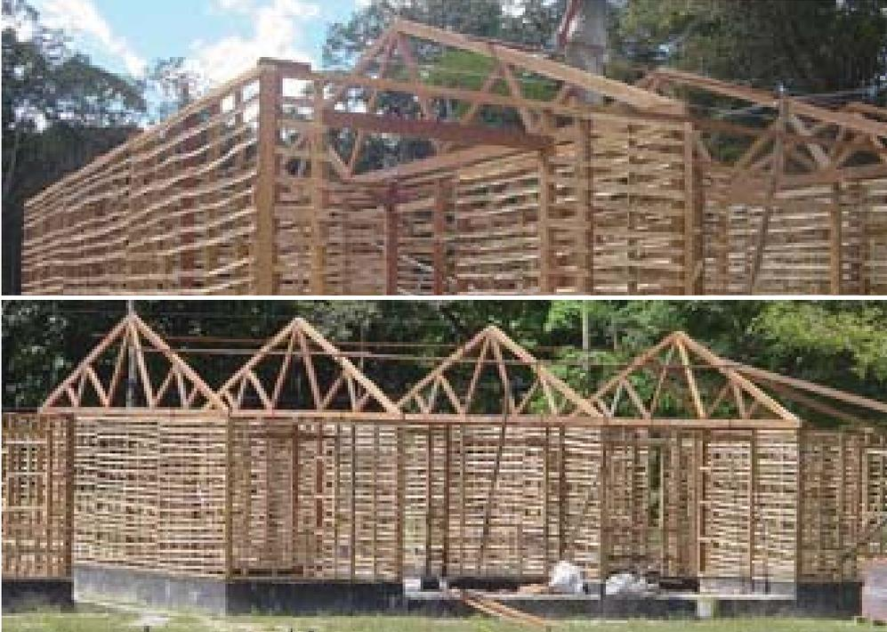
Figura 19. Instalação das tesouras.
